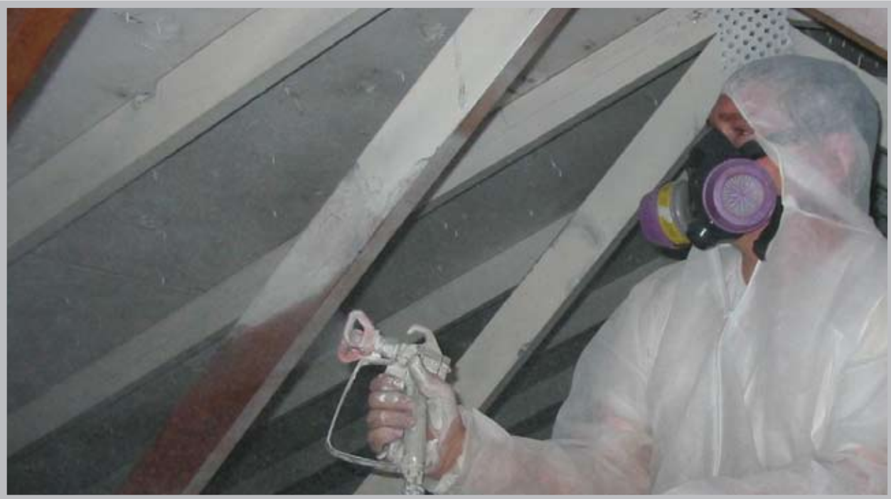
Encapsulado del Amianto.
