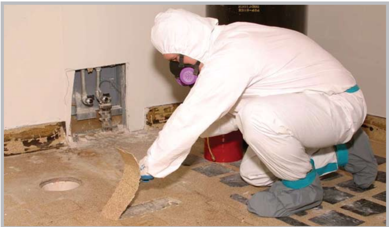
Remoción de Amianto.
