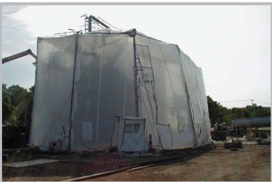
Protección de la zona.
