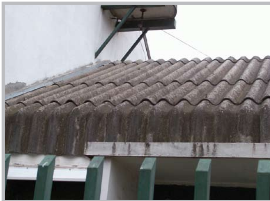
Vivienda unifamiliar con placas de fibrocemento.
