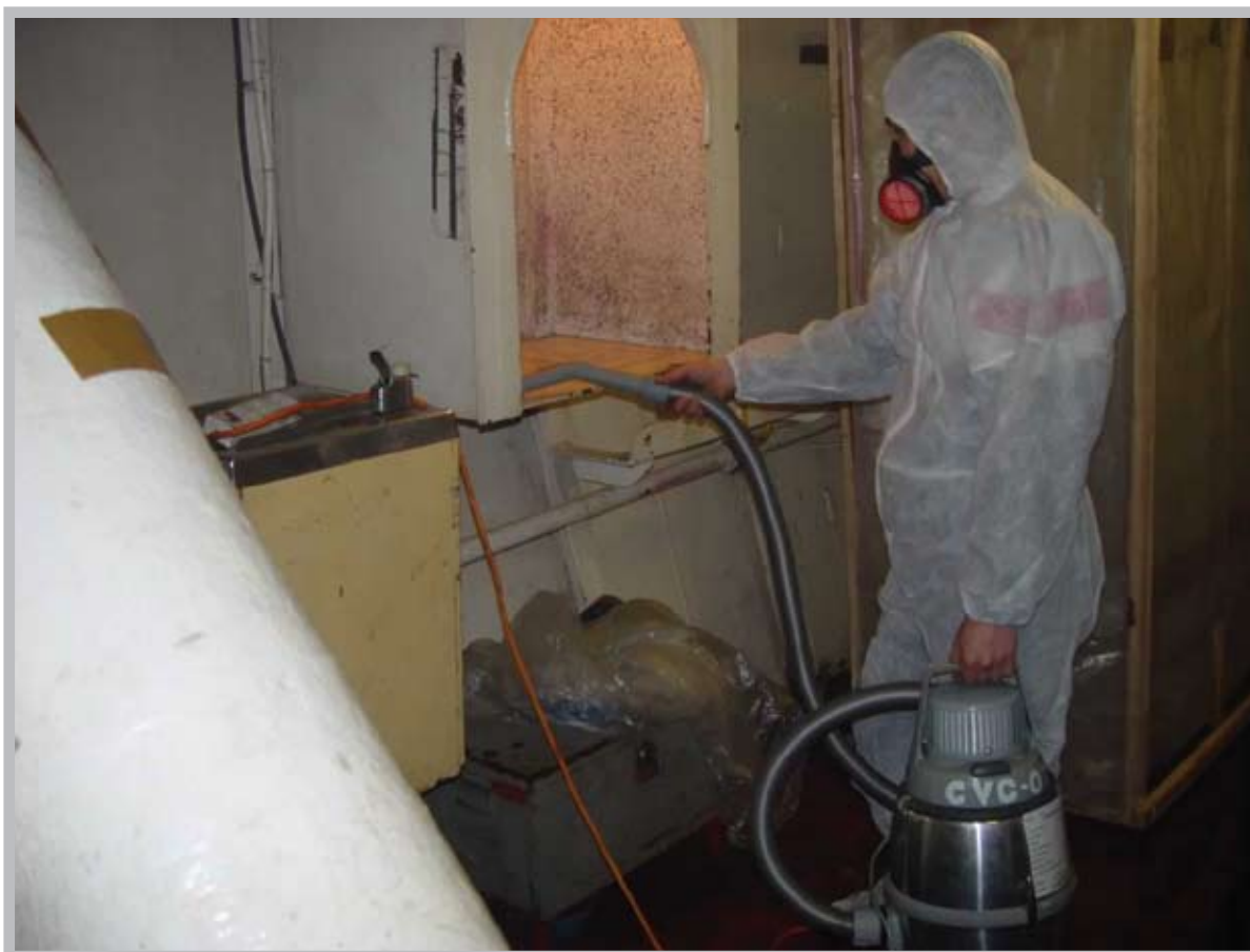
Remoción de polvos de amianto.
