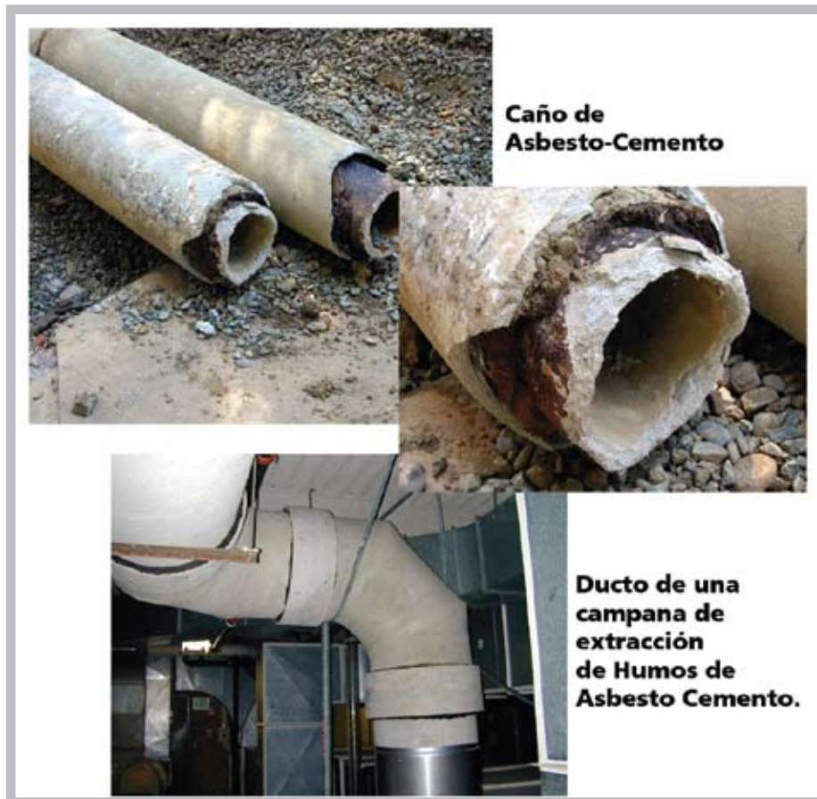
Cañerías de amianto cemento.
