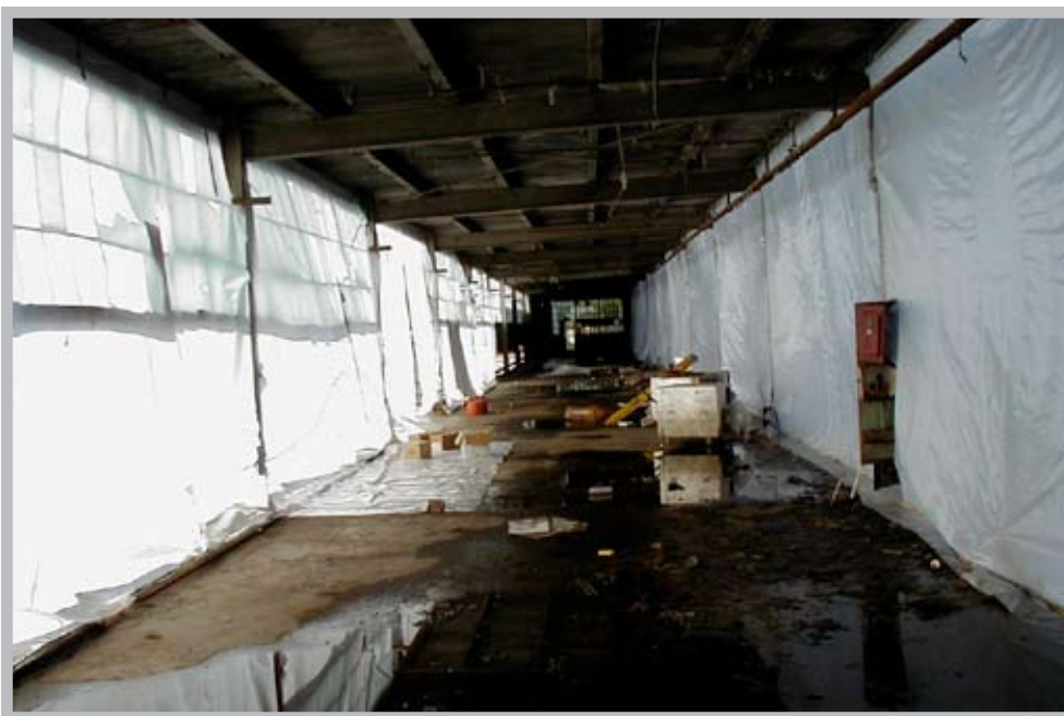
Protección de la zona.
