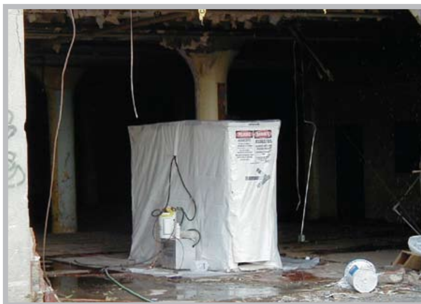
Protección de la zona.
